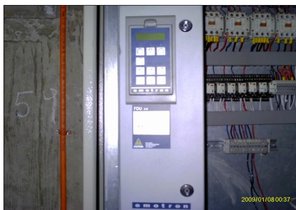
PANEL DE CONTROL CON VARIADOR DE VELOCIDAD
