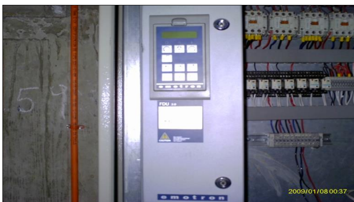
PANEL DE CONTROL CON VARIADOR DE VELOCIDAD
