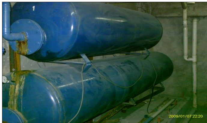
ESTANQUES DEL HIDROPACK
