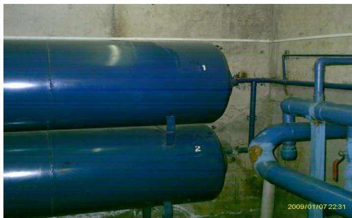
ESTANQUES DEL HIDROPACK
