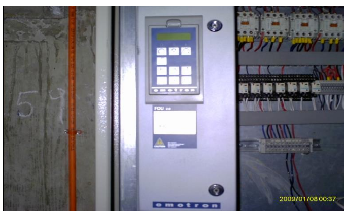
PANEL DE CONTROL CON VARIADOR DE VELOCIDAD
