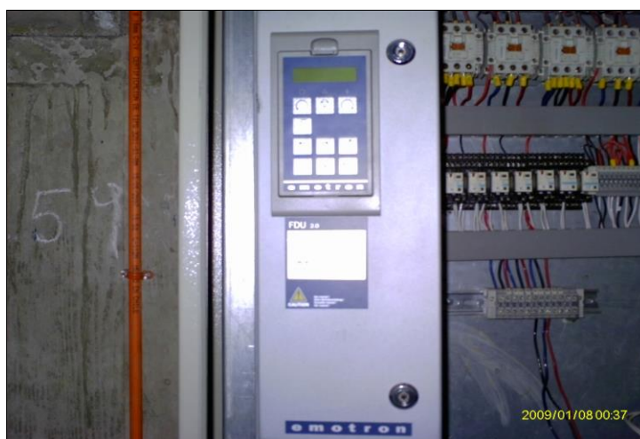
PANEL DE CONTROL CON VARIADOR DE VELOCIDAD
