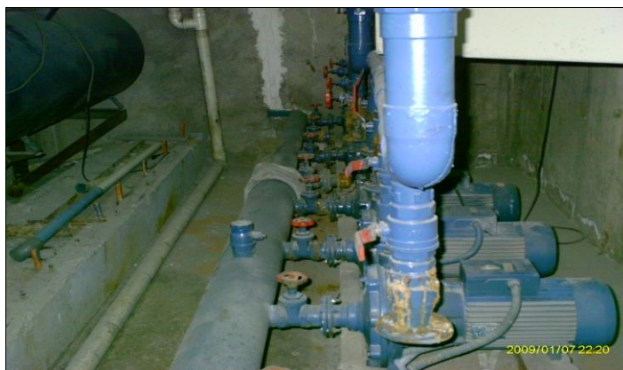
BOMBAS Y MANIFOLD DEL CIRCUITO DE BAJA
