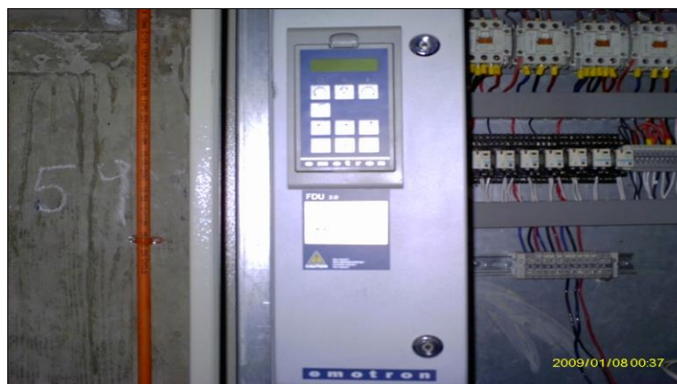
PANEL DE CONTROL CON VARIADOR DE VELOCIDAD
