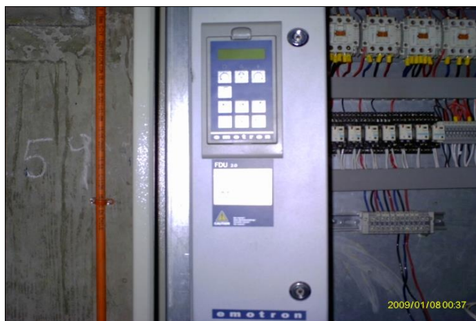
PANEL DE CONTROL CON VARIADOR DE VELOCIDAD
