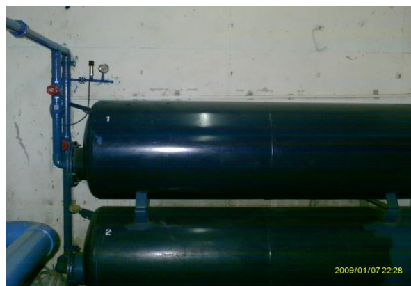
ESTANQUES DEL HIDROPACK
